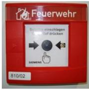
Bei Betätigen eines Druckknopfmelders wird unmittelbar Alarm bei der Feuerwehr ausgelöst.
